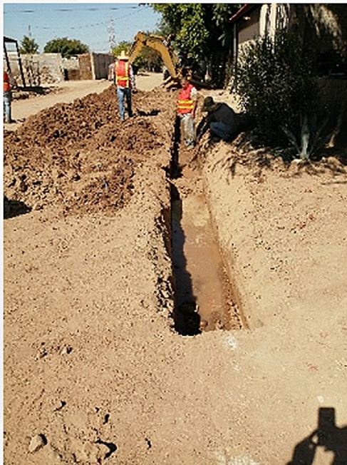
INSTALACIÓN DE DRENAJE PLUVIAL
